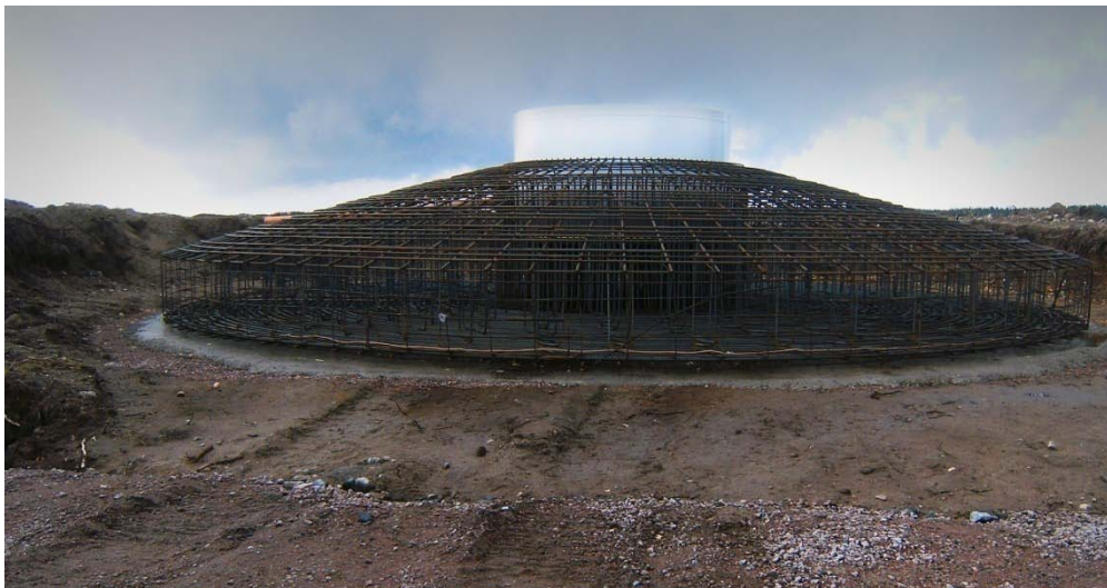
Figur 7 Exempel på färdigställd armering för ett gravitationsfundament
