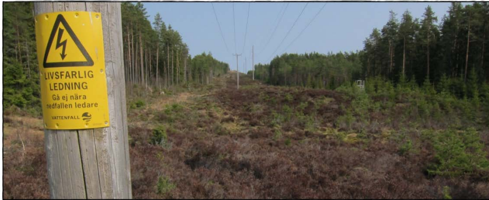
Figur 23: Kraftledningen som löper genom anläggningsområdets sydöstra del.
