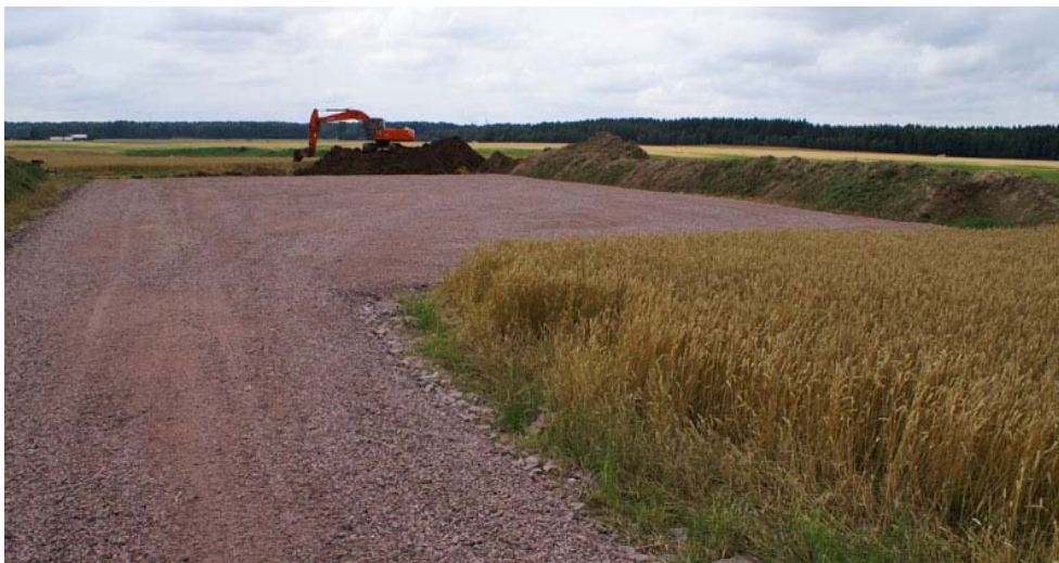
Figur 10 Exempel på kranplats med tillhörande uppläggningsyta
