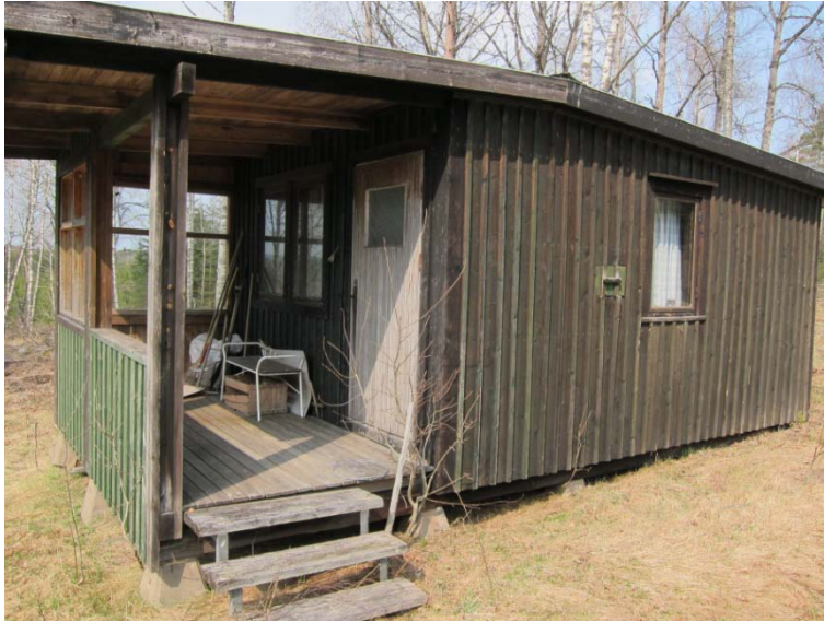
Figur 26 visar byggnaden 250 meter norr om Liden som exkluderats från bullerberäkning.
