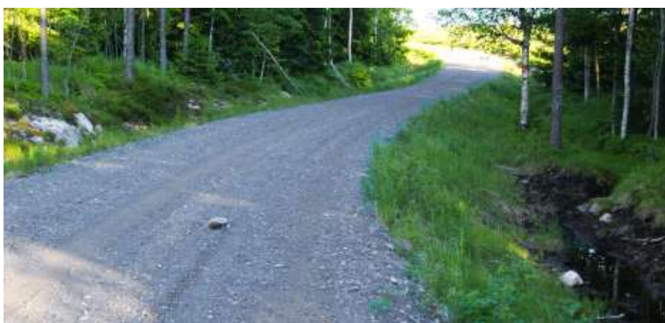
Anslutande väg mot vindkraftverk, Dalarna 2010
