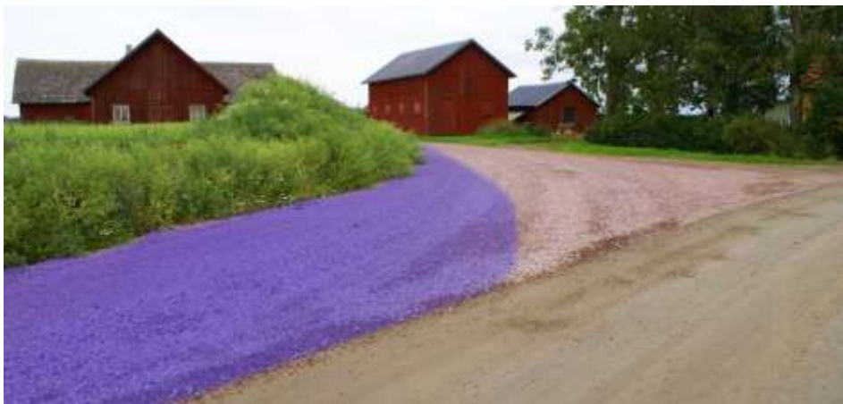
Breddad infart till anslutningsväg mot vindkraftverk, Skara 2009. Blå markering motsvara breddad del.
