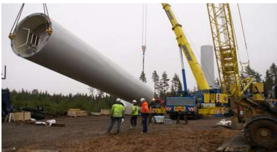
Kranplats, montage, Hjo 2009
