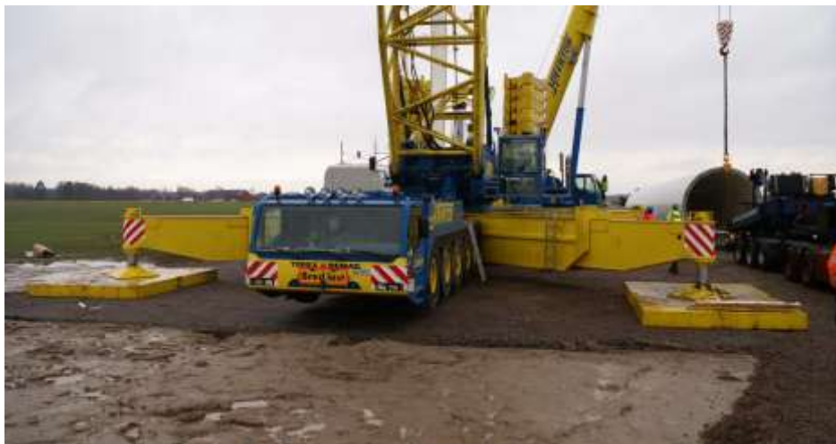
Kranplats, montage, Skara 2009
