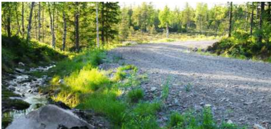
Anslutande väg mot vindkraftverk vid skarp kurva och dikning, Dalarna 2010
