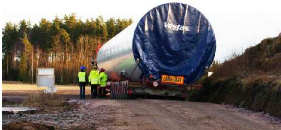
Väg nära kranplats, Skara 2009
