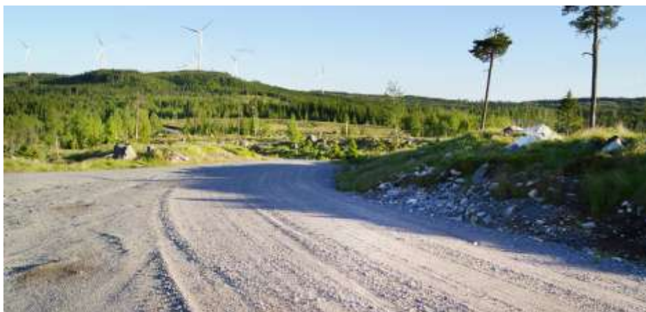
Anslutande väg mot vindkraftverk med mötesplats, Dalarna 2010
