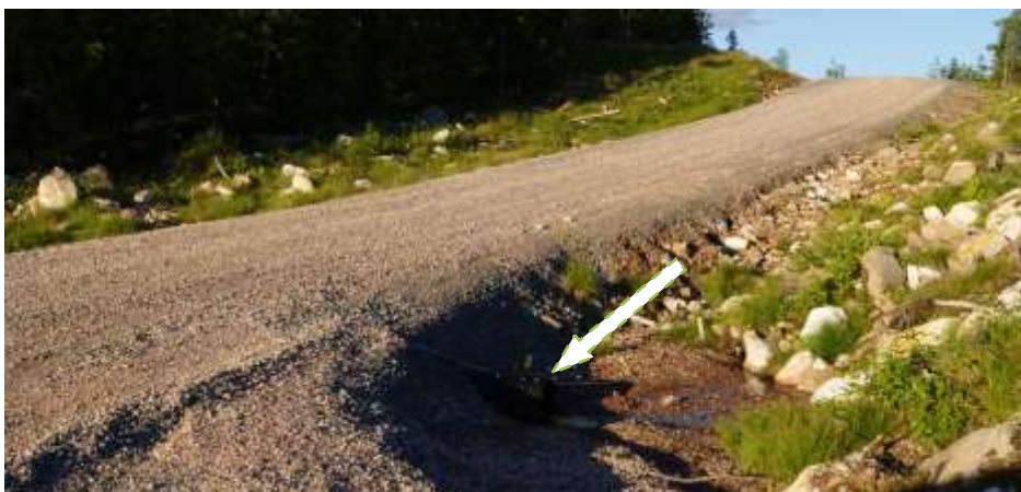
Anslutande väg mot vindkraftverk vid intern korsning samt trumma (pil), Dalarna 2010
