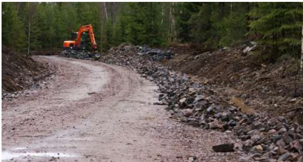
Pågående byggnationer vid Otterbäcken, Västra Götaland 2010
