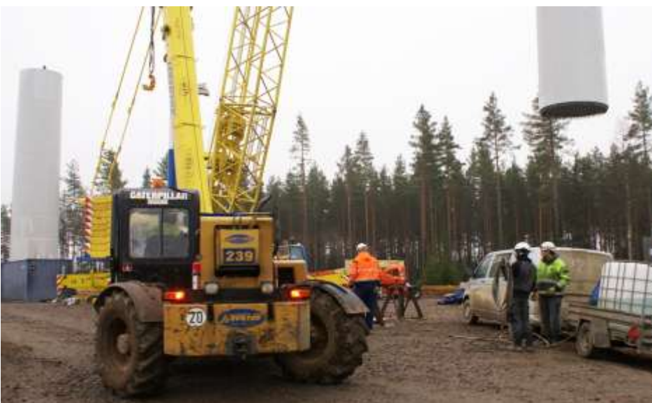
Kranplats, montage, Hjo 2009
