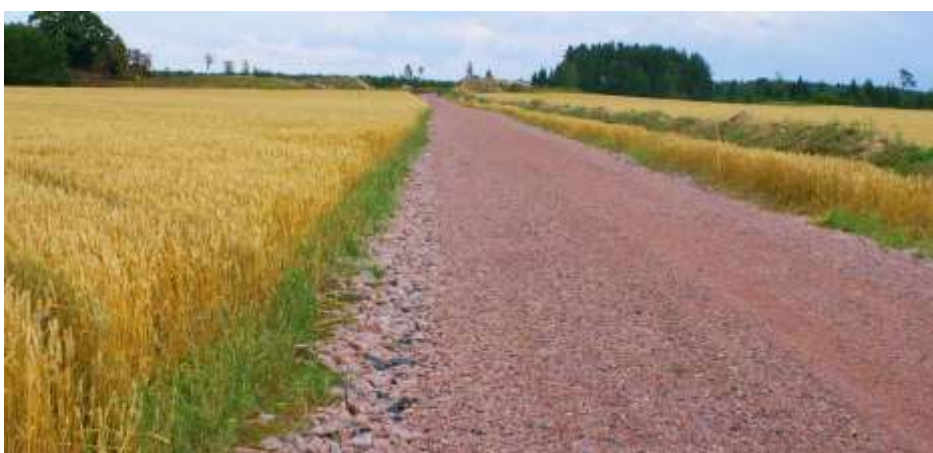
Breddad infart till anslutningsväg mot vindkraftverk, Skara 2009
