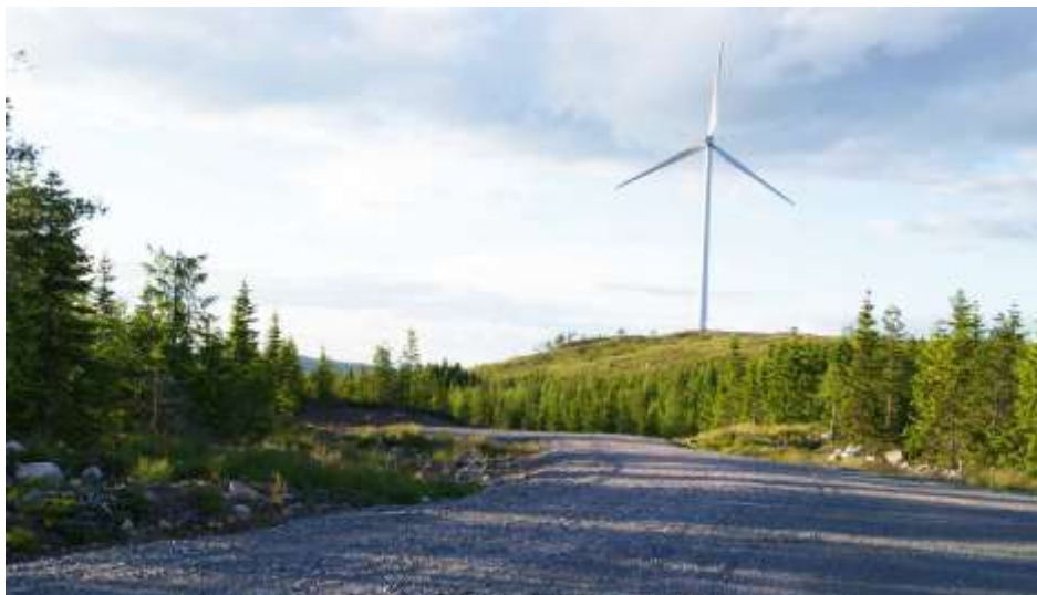
Anslutande väg mot vindkraftverk, Dalarna 2010
