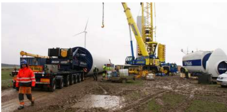
Kranplats, montage, Skara 2009
