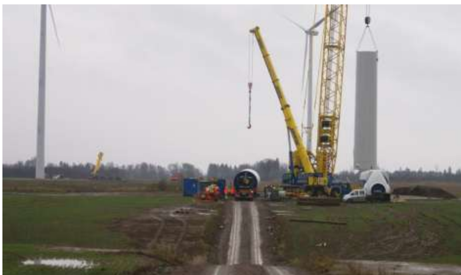
Kranplats, montage, Skara 2009
