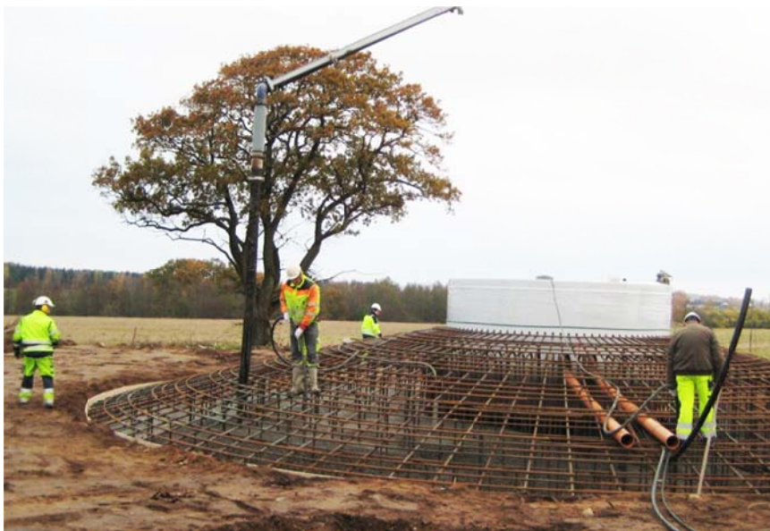
Figur 3 Gjutning av ett fundament i Skara – oktober 2009
